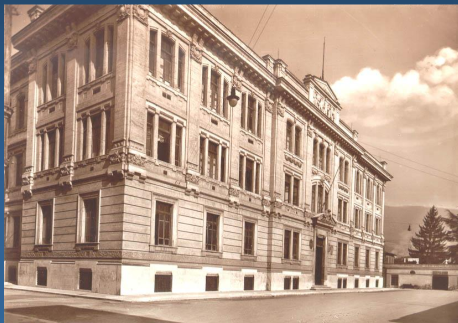
Terni - Istituto Tecnico - Ed. S.E.L.C.A.T. - Alterocca
